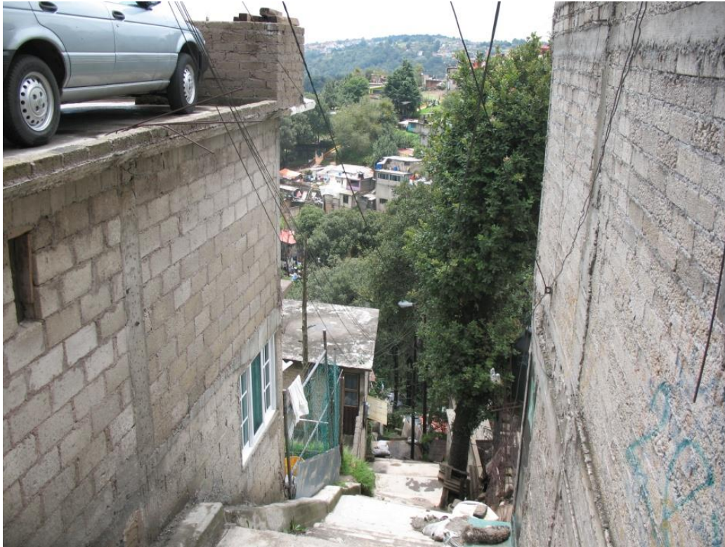
Fotografía 16. Escalinatas en la colonia El Carmen en San Pablo Chimalpa. Las pendientes pronunciadas generan una urbanización “hacia abajo” en donde las viviendas quedan en relieve. En la fotografía se observa como en la vivienda de la izquierda el techo cumple también con la función de garaje. Fotografía por Monserrat Espín, 2011.
