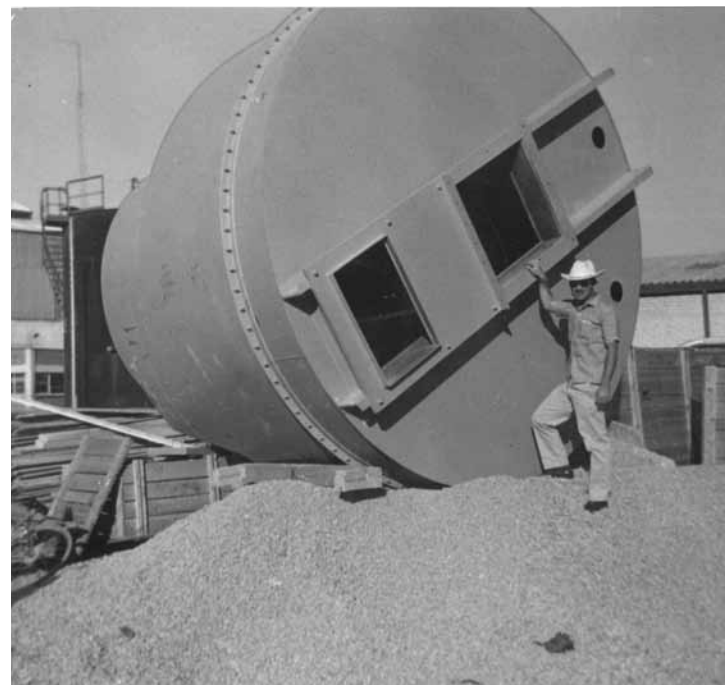
Aspectos de la construcción de la fábrica de TNT, a la vista un tonel para revolver la nitrocelulosa, s/f. Colección Germán Hernández Aguilar.
