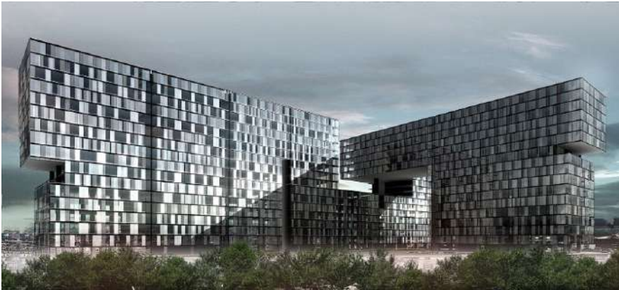
Ilustración 7. Centro comercial y torre corporativa Samara.
