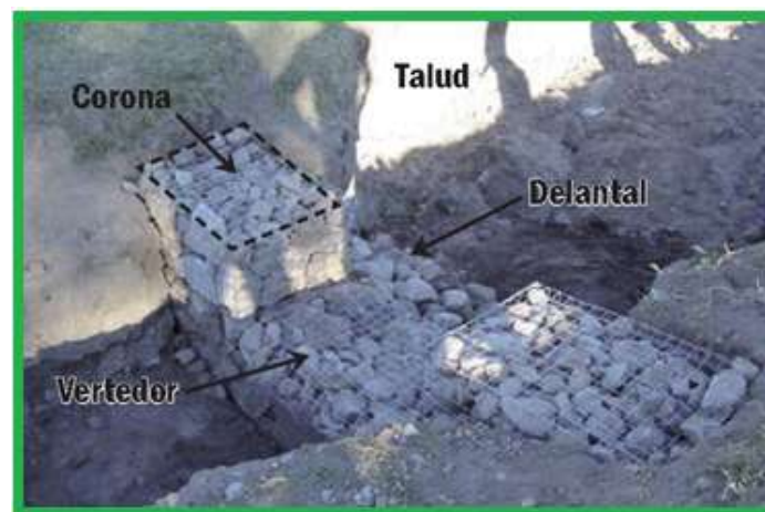
Fig. 27. Presa de malla ciclónica esquematizada.
