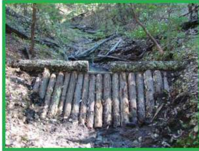
Fig.28. Imagen de una presa de morillos.
