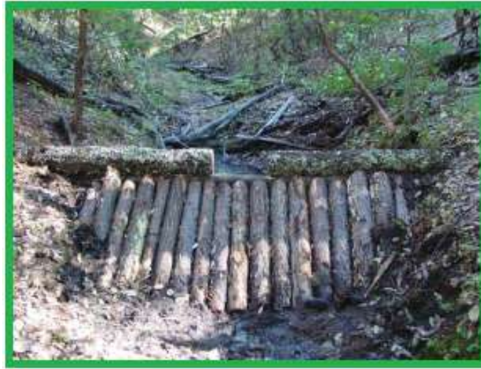
Fig. 30. Imagen de una presa de morillos.
