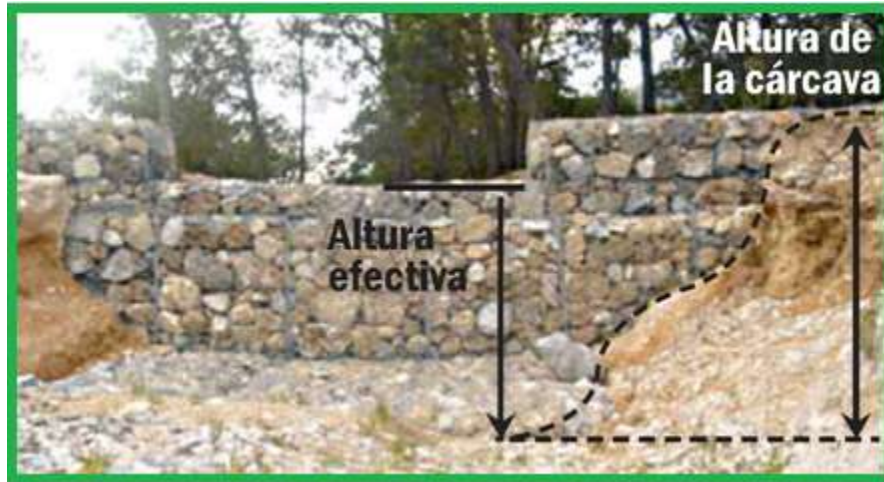
Fig. 33. Esquema de una presa de gavión.
