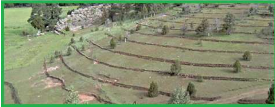
Fig. 18. Técnica de terraceo por formación sucesiva.
