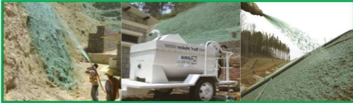
Fig. 38. Imágenes del proceso de hidrosiembra.
