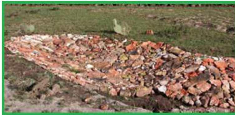
Fig. 9. Cabeceo de una cárcava.
