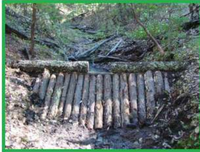
Fig. 31. Imagen de una presa de morillos.
