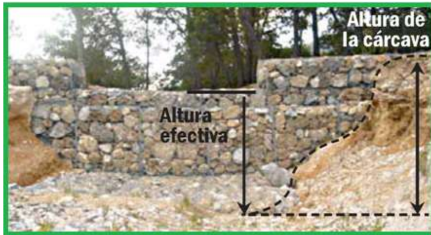
Fig. 33. Esquema de una presa de gavión.
