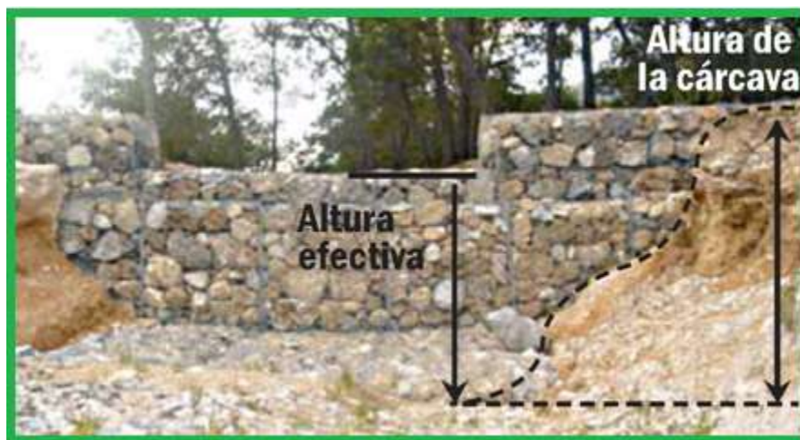
Fig. 32. Esquema de una presa de gavión.
