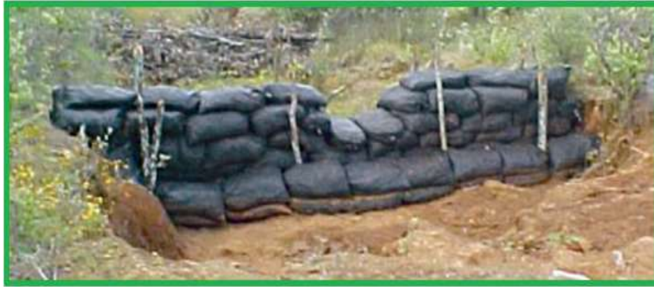
Fig. 25. Imagen de una presa de geocostal.
