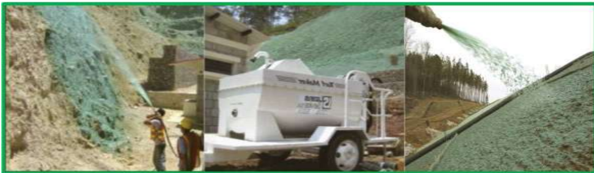
Fig. 37. Imágenes del proceso de hidrosiembra.
