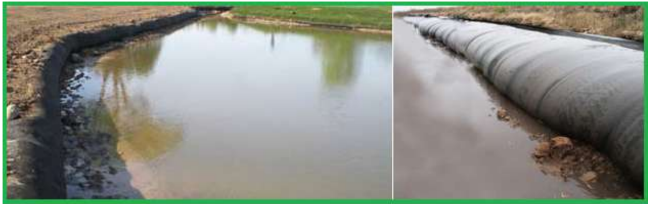
Fig. 12. Uso de geotubos para protección de los márgenes de un cauce.
