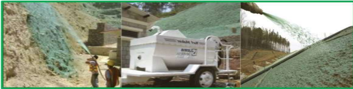
Fig. 37. Imágenes del proceso de hidrosiembra.
