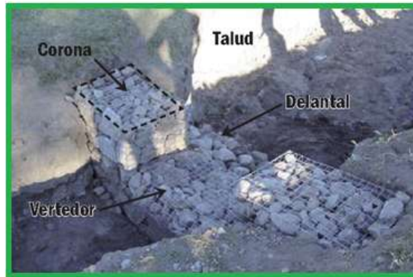
Fig. 30. Presa de malla ciclónica esquematizada.
