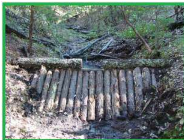
Fig. 31. Imagen de una presa de morillos.
