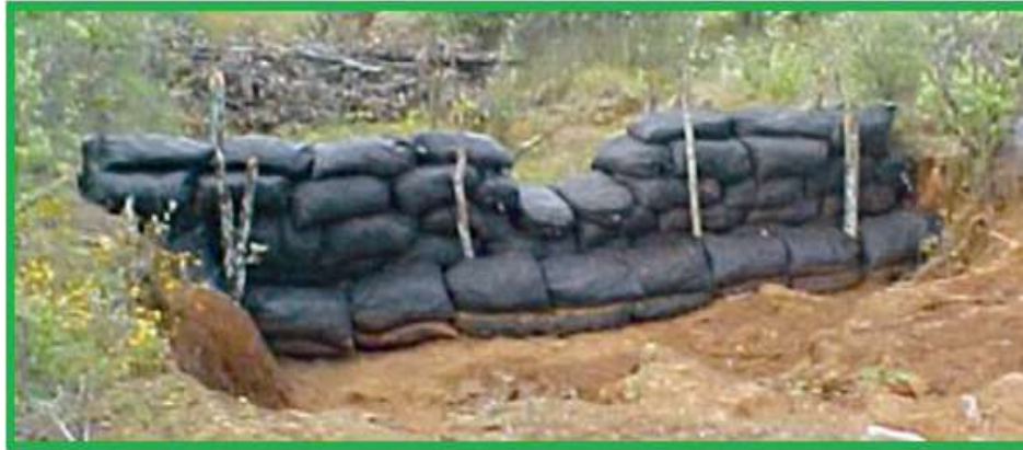
Fig. 28. Imagen de una presa de geocostal.
