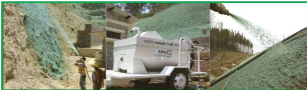
Fig. 38. Imágenes del proceso de hidrosiembra.
